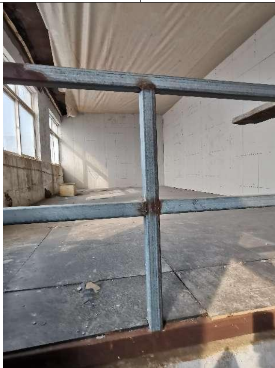
危险废物暂存间-建设中
