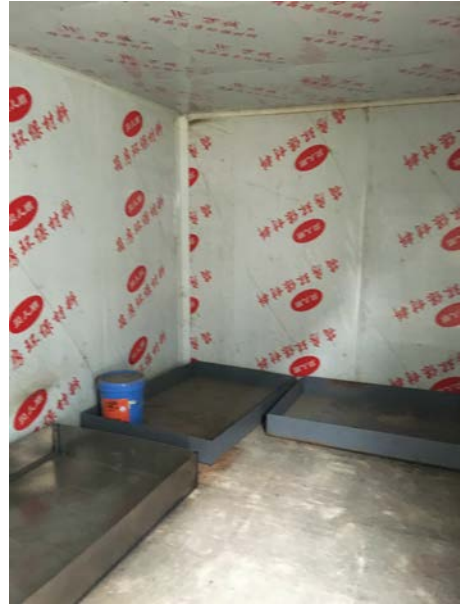
危废间-防腐防渗漏托盘、地面防腐防渗
